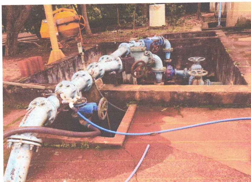
EEAT 01 - Fonte: Visita Técnica
