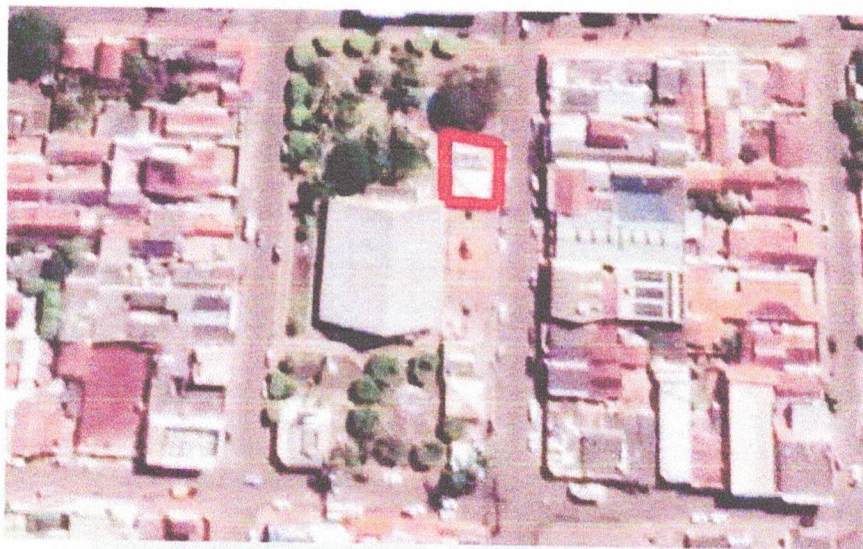
Figura 1: Vista Aérea Quiosque – Praça das Mães.
