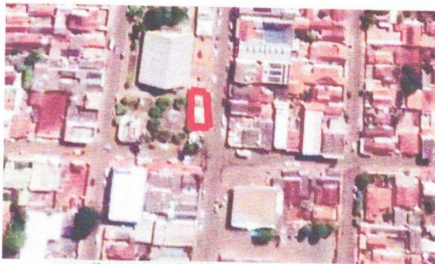
Figura 1: Vista Aérea Quiosque – Praça das Mães.
