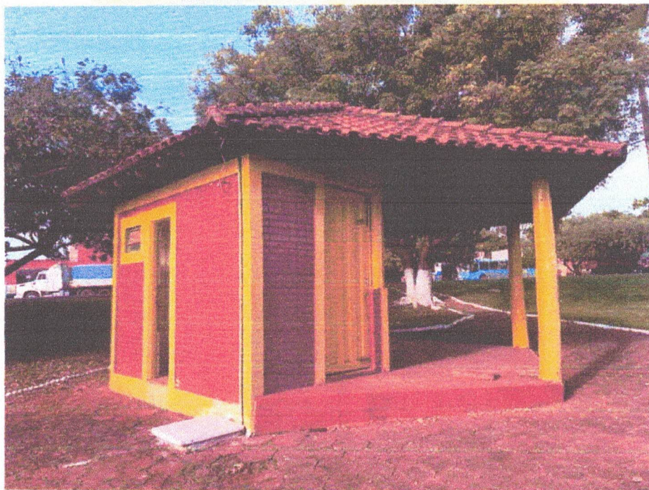
Figura 4: Vista Lateral Direita do Quiosque – Margem da Rod. GO 174.
