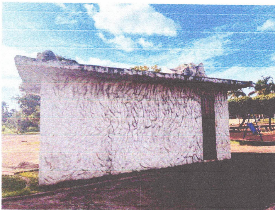
Figura 5: Vista Fundo do Quiosque – Praça dos Dinossauros.
